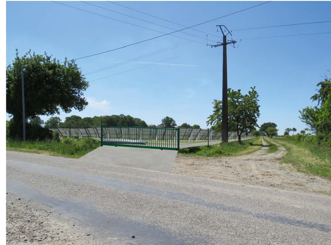
Etat final du site avant renforcement de la haie existante
