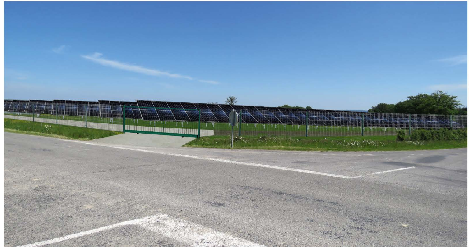
Etat final du site avant renforcement de la haie existante
