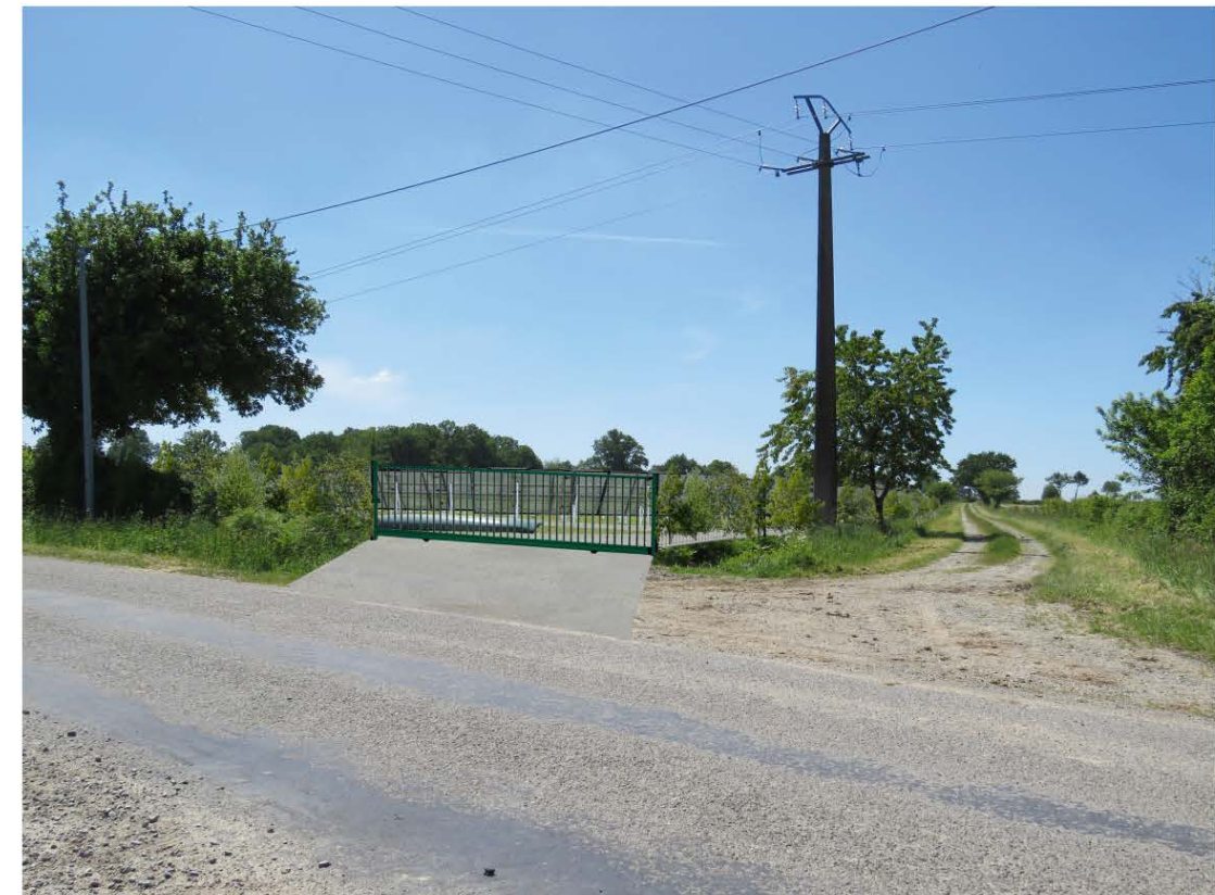
Etat final du site avec renforcement de la haie existante
