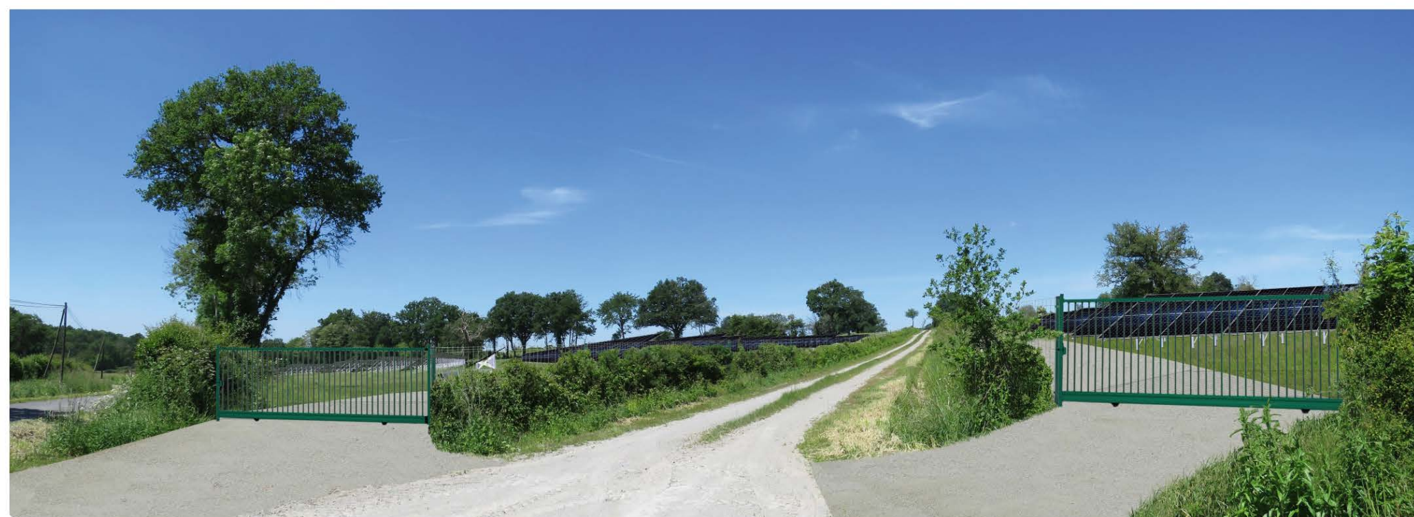
Etat final du site
